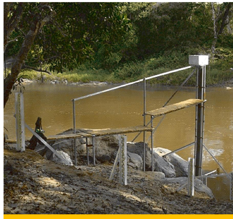
Photo 2 : Installation d'équipement de mesure des crues
