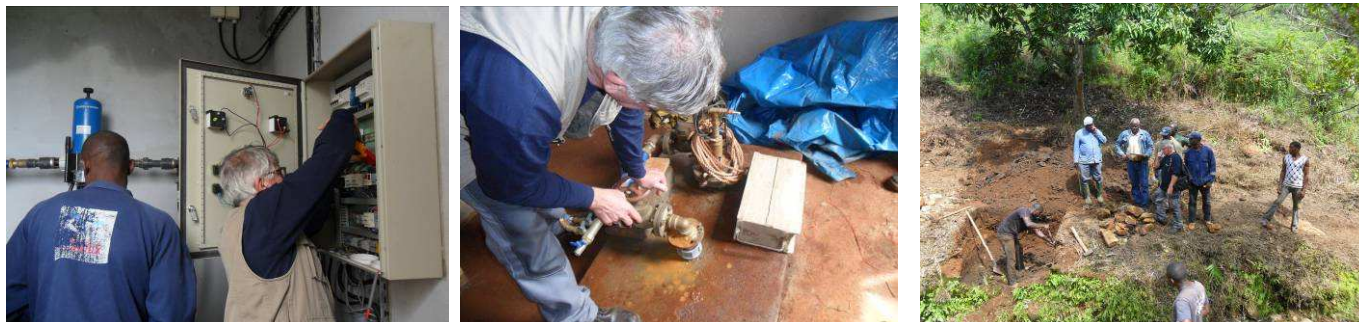
De gauche à droite : Bernard Cotton sur une armoire électrique de Bangoulap ; au forage de Bahouoc ; au captage de Batchingou.
