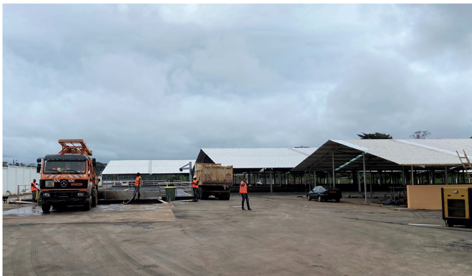
Station de Traitement des Boues de Vidange d'Etoa
