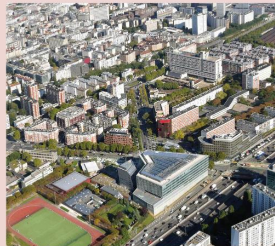
Vue aérienne des programmes de bureaux des îlots Ouest et Est ainsi que de la Maison Internationale de Séjour, le long du boulevard périphérique
